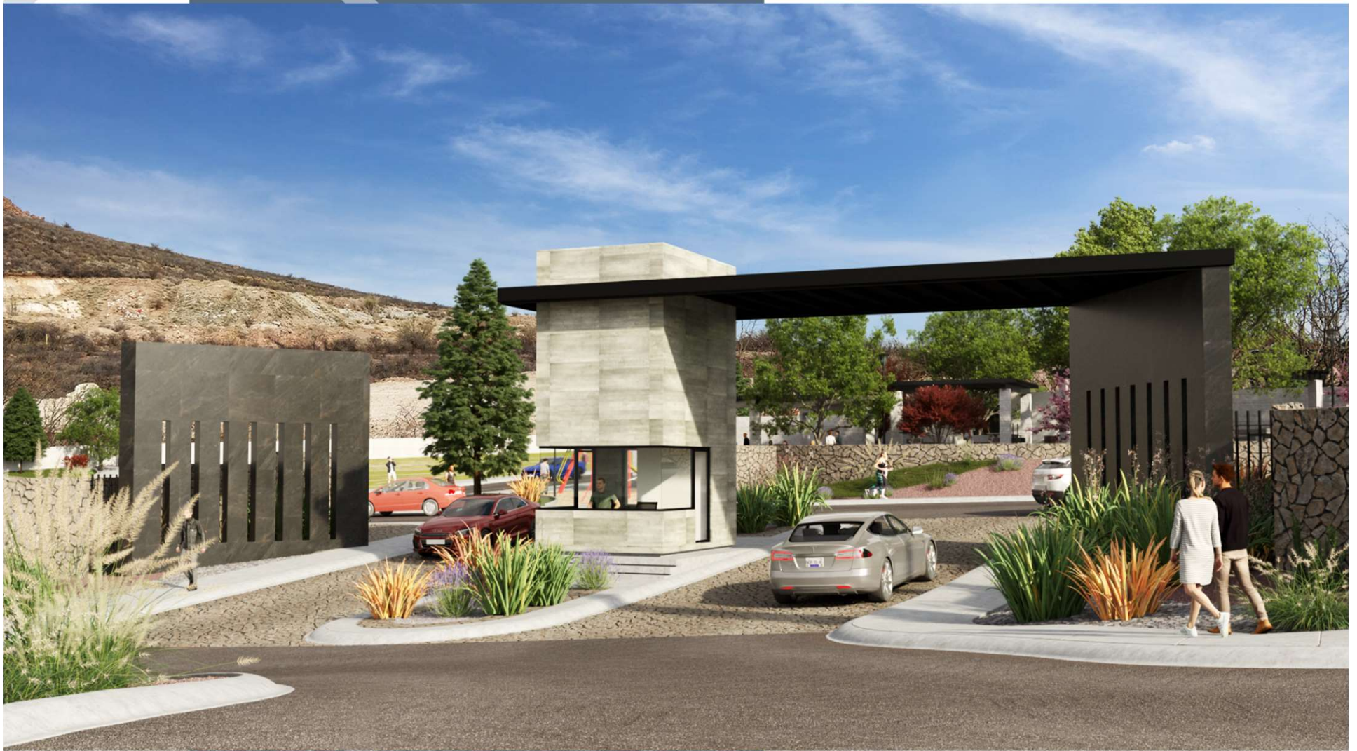
VISTA DE CASETA PRINCIPAL – ACCESO A DENALI REJÓN
